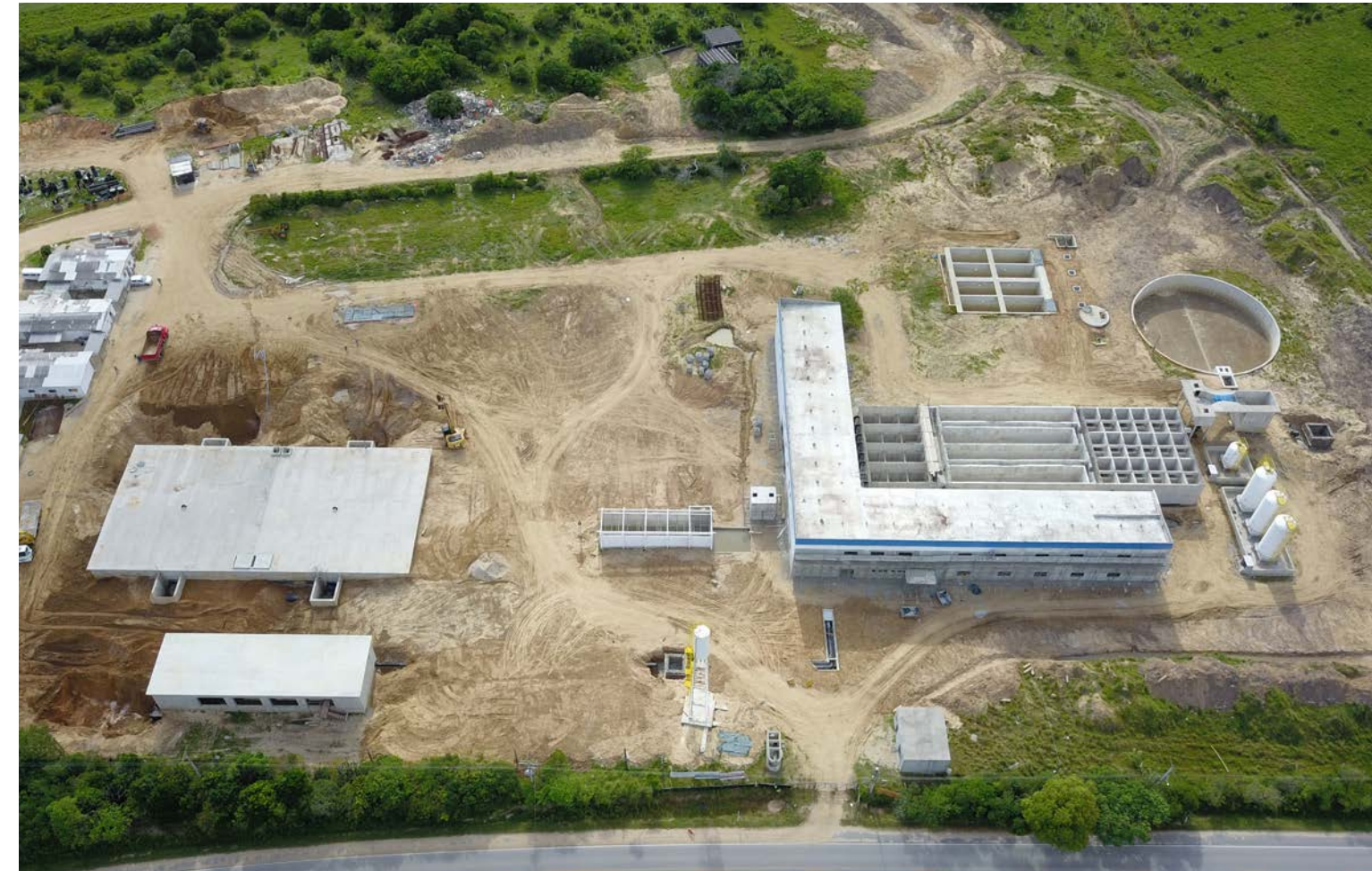
Construção da nova Estação garante o abastecimento de água pelos próximos 30 anos
