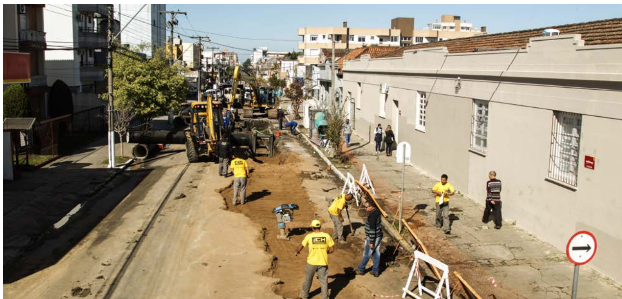
Tubulações percorrem a área central pela rua Barão de Santa Tecla
